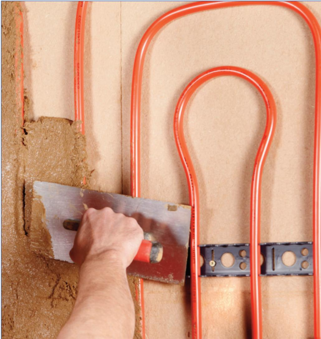
Wandheizungs- und Wandkühlungssysteme auf Wasserbasis sind **aus technologischer Sicht einfach** zu installieren.
