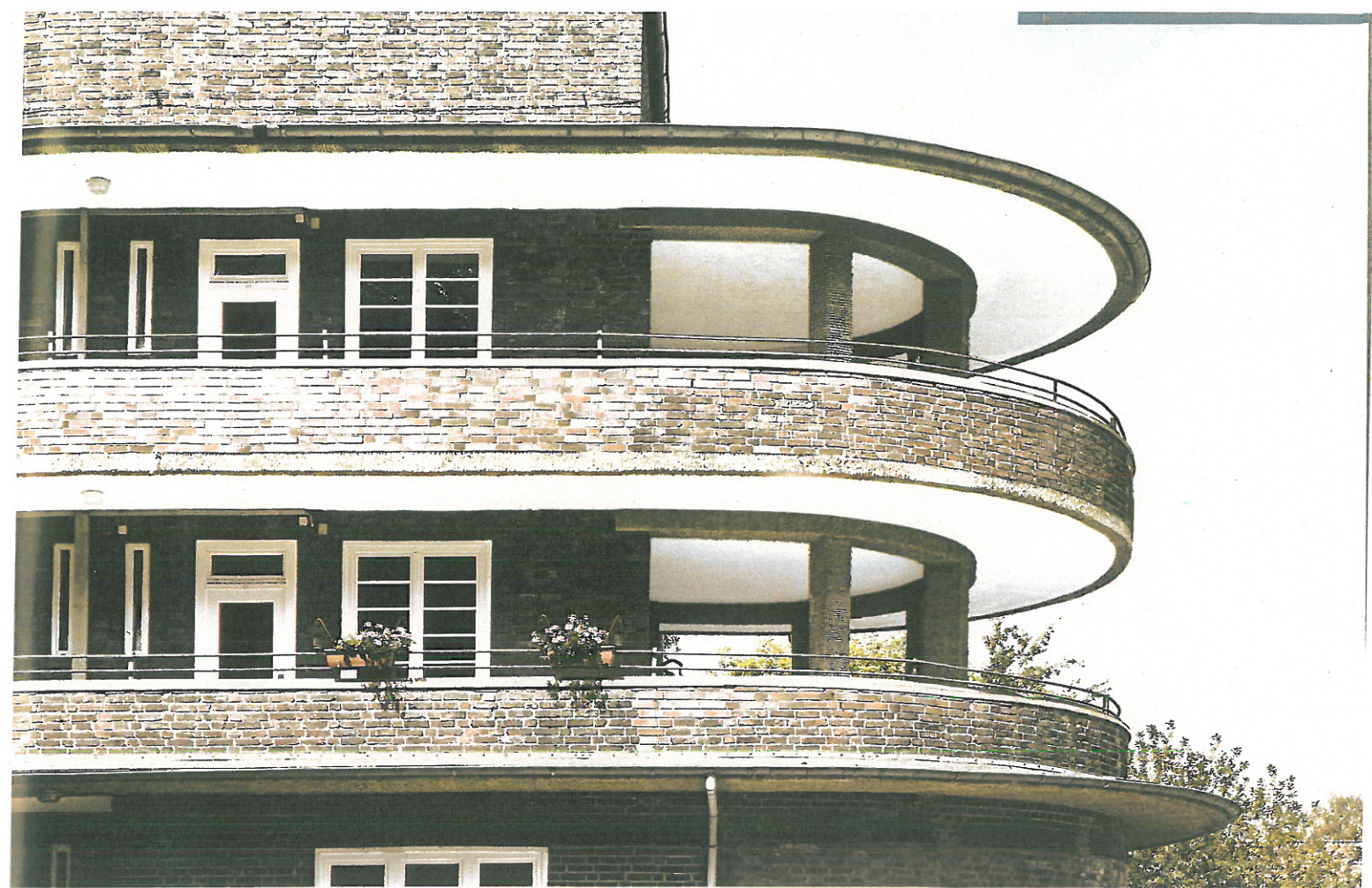
Laubengangsiedlung in Hamburg-Dulsberg
