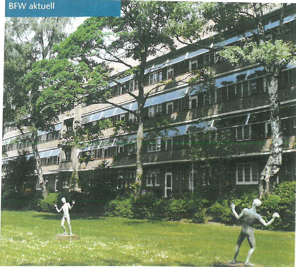
Laubengangsiedlung in Hamburg-Dulsberg
