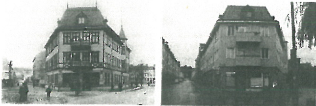
2 pav. Istorinio pastato apšiltinimo pavyzdys Švedijoje, kai buvo labai pagerintas energinis efektyvumas, bet sunaikintas pastato autentiškumas
