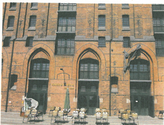
Sanierter alter Kaispeicher B in der Hamburger Speicherstadt, heute Maritimes Museum. Foto: AZB Hamburg
