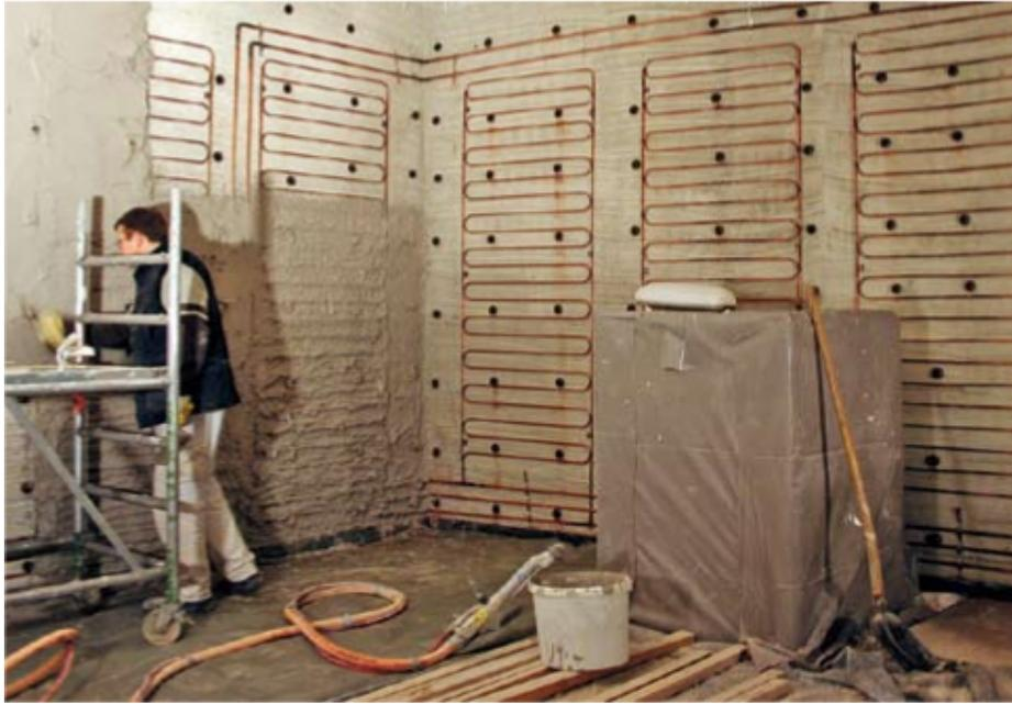
Abbildung 3.1: Montage eines Hypoplan-Wandheizungssystems (aus: [12])
