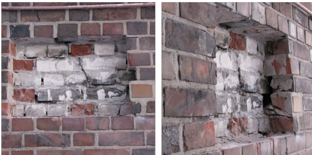
Abbildung 36 Ansicht Mauerwerksaufschluss im Bereich Passierzettel 9 – Der Mauerwerksaufbau entspricht im Wesentlichen dem der vorangegangenen Beispiele
