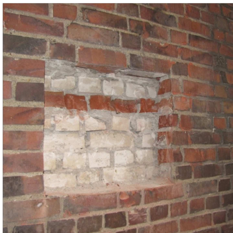
Abbildung 39 Mauwerksaufschluss auf der Rückseite des Gebäudes (Zugang Wilhelmsburger Straße – hier wurde eine komplette Binderschicht für den Verbund zwischen Außenschale und Hintermauerwerk eingefügt.
