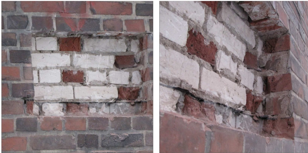
Abbildung 35 Ansicht Mauerwerksaufschluss im Bereich Passierzettel 4 – im linken Foto erkennbar sind regelmäßig angeordnete Binder zur Verbindung von Hintermauerwerk und Außenschale erkennbar, auch hier schließen beide Schalen nahtlos aneinander an (Foto rechts)
