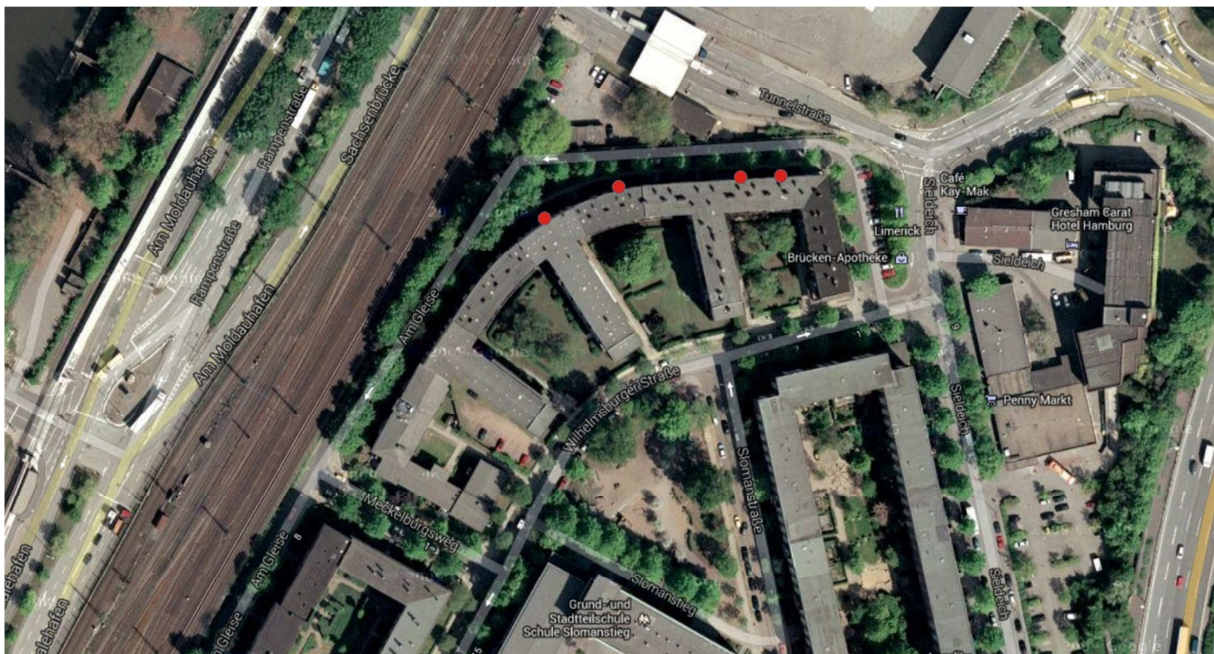
Abbildung 2 Lage der Wohneinheiten im Gebäude (rot markiert) – v.l.n.r.: Am Gleise 2, Passierzettel 9, Passierzettel 3, Passierzettel 1 (Bildquelle: Google Maps, 30.06.2013)
