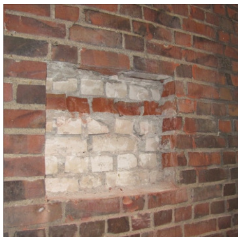
Abbildung 37 Mauwerksaufschluss auf der Rückseite des Gebäudes (Zugang Wilhelmsburger Straße – hier wurde eine komplette Binderschicht für den Verbund zwischen Außenschale und Hintermauerwerk eingefügt.
