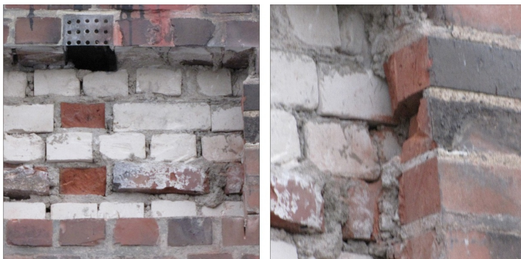
Abbildung 32 Ansicht Mauerwerksaufschluss im Bereich Passierzettel 1 – links: Lüftungsöffnung, rechts: direkter Anschluss des Hintermauerwerks an die Außenschale
