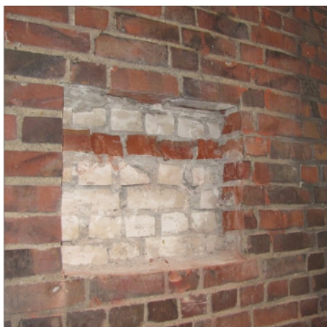
Abbildung 37 Mauewerksaufschluss auf der Rückseite des Gebäudes (Zugang Wilhelmsburger Straße – hier wurde eine komplette Binderschicht für den Verbund zwischen Außenschale und Hintermauerwerk eingefügt.
