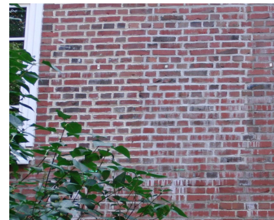
Fleckenbildung durch Salzauswaschung
