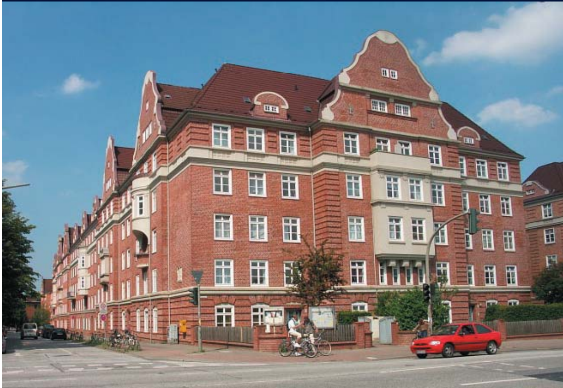
Stresemannstraße/Schützenstraße H. Meyer /Altonaer Spar- und Bauverein 1921-28
